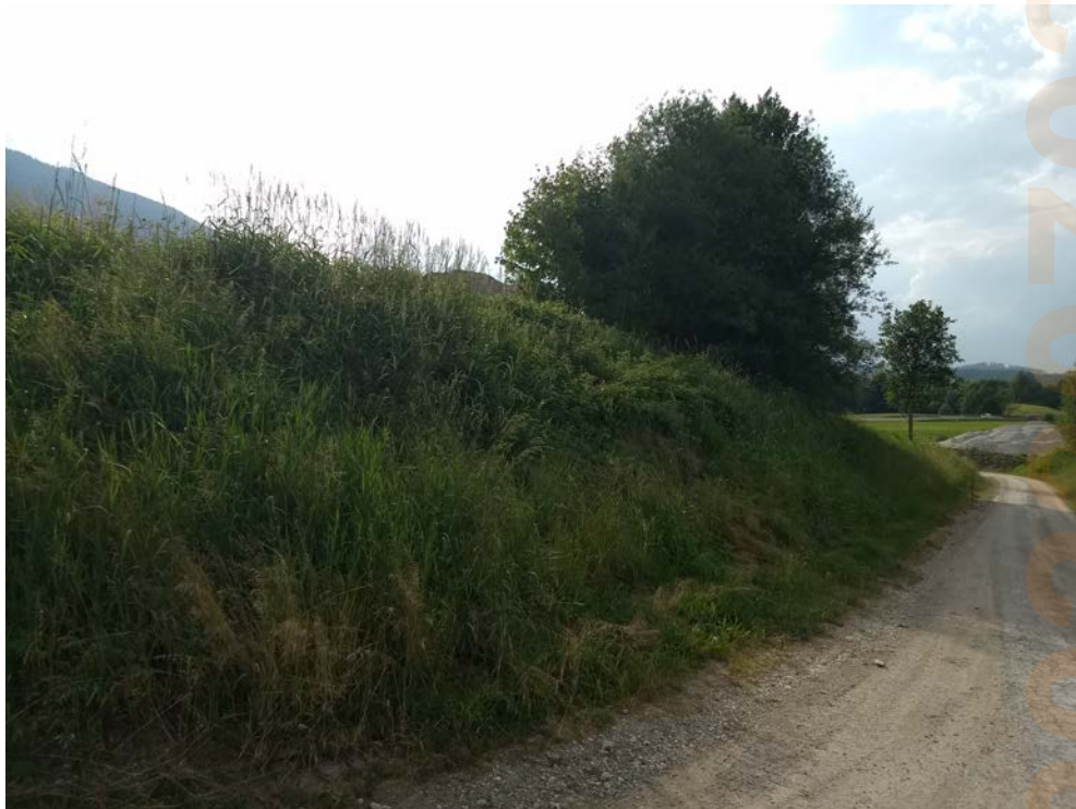
Bestehende Auffüllung, Blick am Rand des Geltungsbereichs nach Nordwesten
